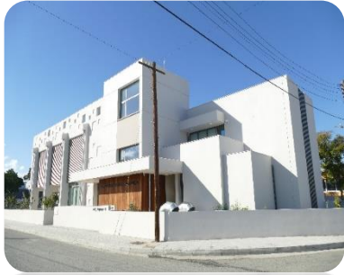
Η Στέγη Ενηλίκων
