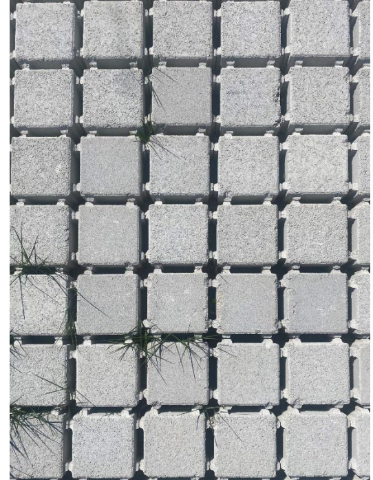
Υδατοδιαπερατοί (Permeable) Κυβόλιθοι σε διαδρόμους
