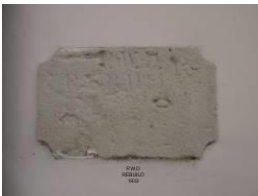
Εντοιχισμένη πλάκα που γράφει: «PWD REBUILD 1933»
